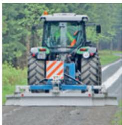
Damit die Funktionsfähigkeit der Abfuhrwege lange erhalten bleibt, werden sie regelmäßig gepflegt. Dabei wird das durch Fahrbewegungen an die Wegeränder verteilte Wegebaumaterial mit speziellen Anbaugeräten wieder auf die Fahrbahn geholt.
