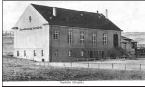
Bild 4: Turnhalle Stadtbadstraße nach der Fertigstellung
